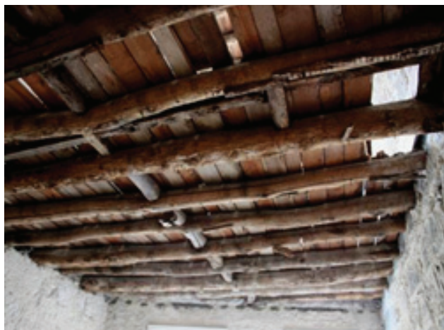
Figura 1 Pavimento de madeira de uma construção antiga de alvenaria. Vigas de secção transversal circular
