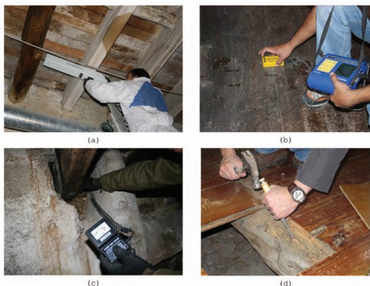
Figura 4 - Ensaio de avaliação do estado de conservação de peças de madeira: (a) Resistógrafo; (b) Pacómetro; (c) Higrómetro; Martelo e formão.
