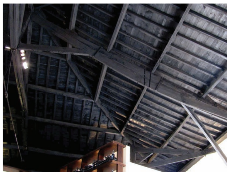
Figura 1. Encurvadura da perna das asnas
