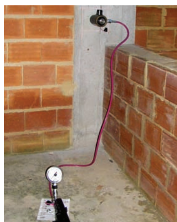
Figura 7. Ensaio pull-out em pilar
