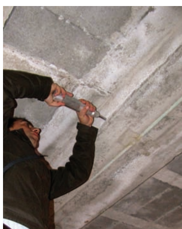
Figura 6. Ensaio com esclerómetro de Schmidt em viga
