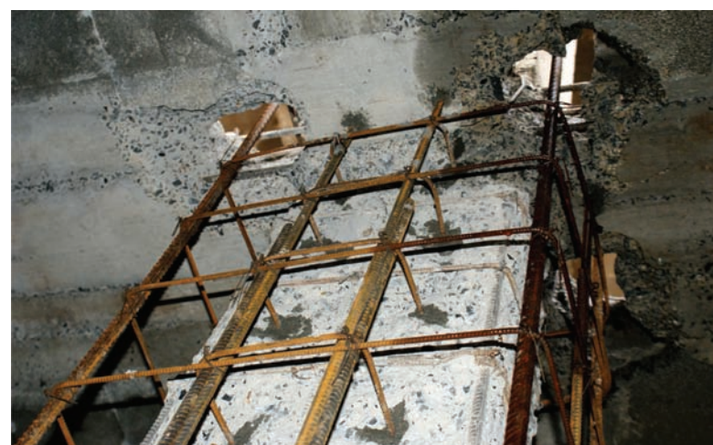
Figura 9. Reforço de pilar com encamisamento em micro-betão, com ligações e continuidade entre piso
