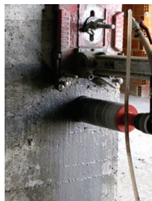
Figura 8. Extracção de carote
