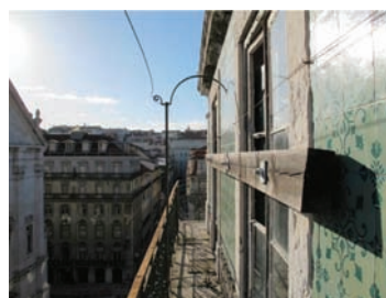
Figura 6. Contenção provisória da fachada ao nível do piso 4
