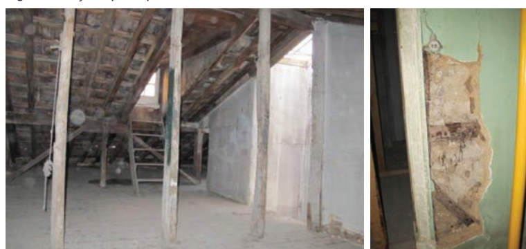
Figura 3. cobertura em madeira.
