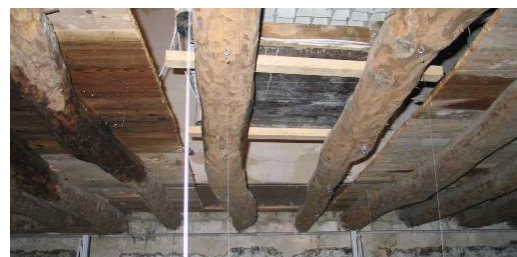
Fig. 8 – Ensaio 3, vigas isoladas.
