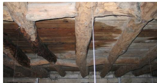
Fig. 6 – Ensaio 1, pavimento com tarugos e soalho.
