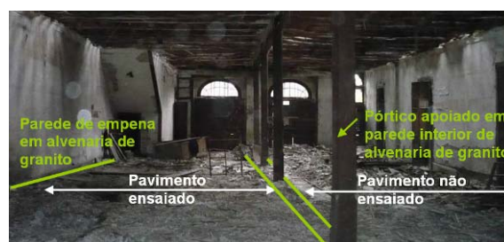
Fig. 2 – Esquema do pavimento ensaiado.
