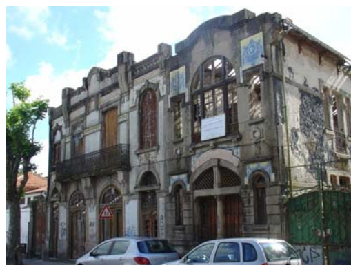
Fig. 1 – Fachada principal do edifício.
